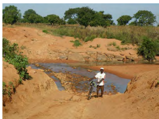
写真 2-10 ダパオンから東へ延びる地方道、河川渡河部、礫を敷き詰めて渡りやすくしてある、サバネス州、Naki Est 付近、2009/11/12
