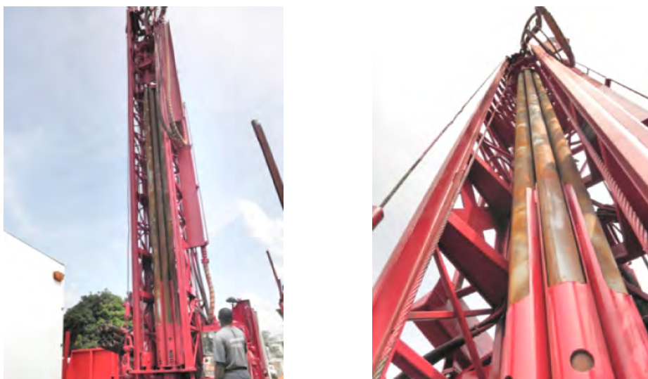
写真 2-11 a (左) , b (右) 掘削機マガジンラック (ローカル業者所有)
