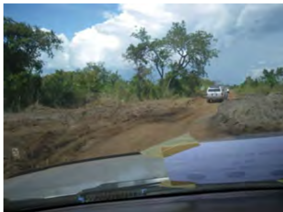
写真 2-3 地方の道路状況、未舗装で降雨により容易に泥濘化し、大型トラックの進入は困難となる。プラトー州 Agblegan 村近く、2009/10/29
