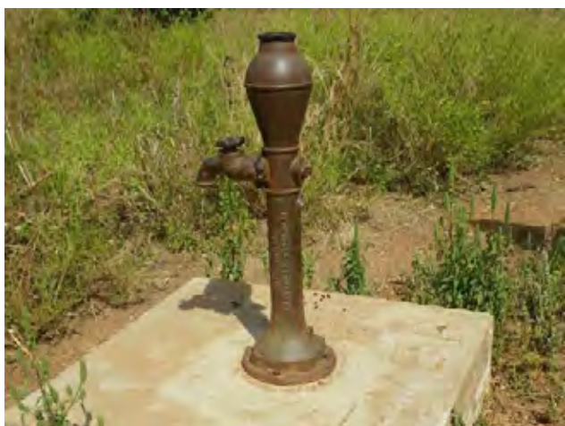
3) 故障し放置された人力ポンプ (アメリカ製) 付き深井戸 (1989 年施工) サバネス州 Timbou 村 センター地区 2009/11/14
