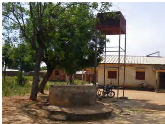
8) コンクリート浅井戸、病院用に上部を閉鎖し人力ポンプで高架水槽に水をあげている。 サバネス州 Timbou 村センター地区 2009/11/14
