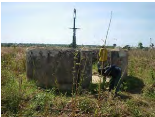
3) 故障し放置された人力ポンプ (アメリカ製) 付き深井戸 (1989 年施工) サバネス州 Timbou 村 センター地区 2009/11/14
