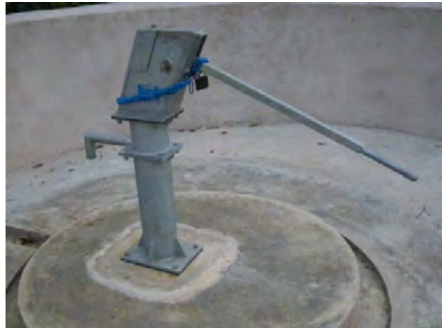
6) 完成したばかりのレベル 1 施設、PB Mark II ポンプ (SBF-HAGUSTA)、AFD プロジェクト プラトー州 2009/11/16
