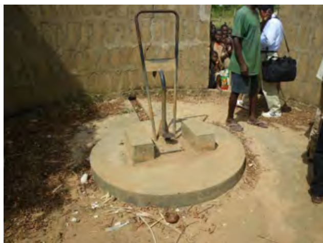
4) 故障し放置された人力ポンプ付き深井戸、5 年から故障、Vergnet-100 型ポンプ マリタイム州 Lankouvi Avoeme 村 2009/11/02
