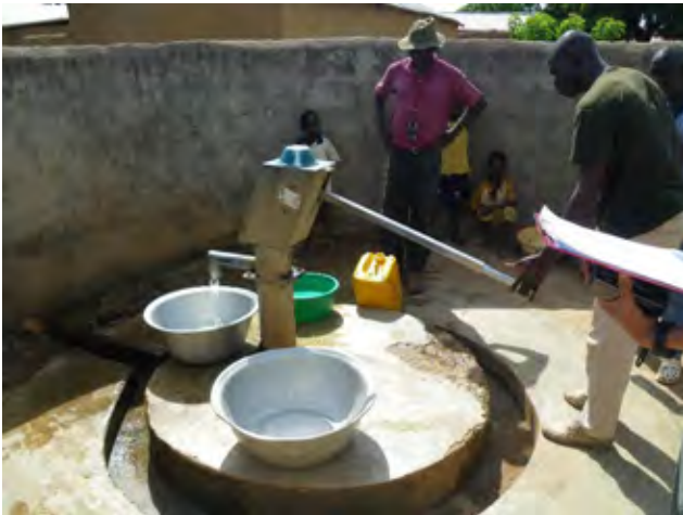
5) 稼動中的人力ポンプ付き深井戸、India Mk II ポンプ サバナネス州 Timbou 村 センター地区 2009/11/14
