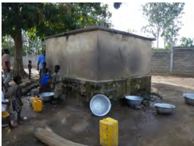
7) モノ河に造られた Nangbéto 湖から配水、塩素滅菌処理で飲用。 プラトー州 Assante Agnibahoe 村 2009/11/16
