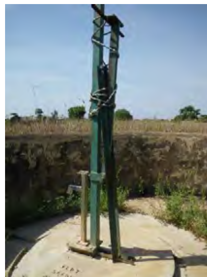
4) 故障し放置された人力ポンプ付き深井戸、5 年から故障、Vergnet-100 型ポンプ マリタイム州 Lankouvi Avoeme 村 2009/11/02
