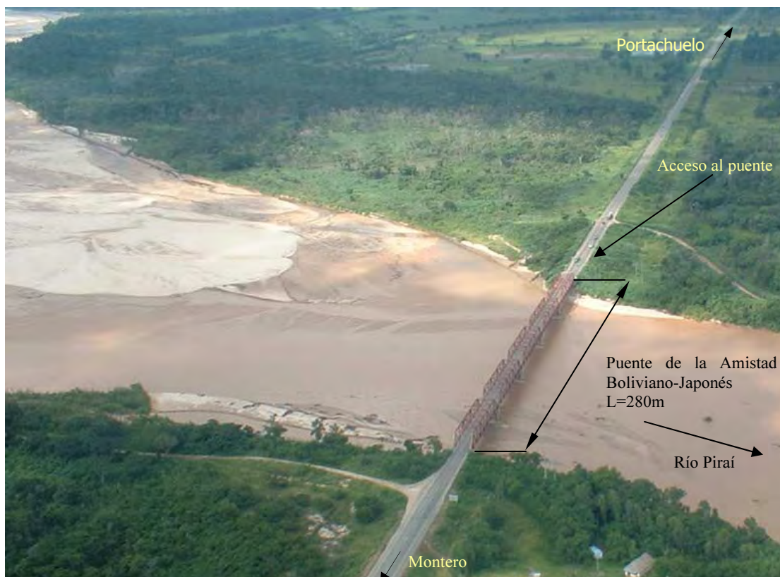
Figura 2-2-1 Situación del Puente de la Amistad Boliviano-Japonés y sus accesos (Foto: febrero 2001)
