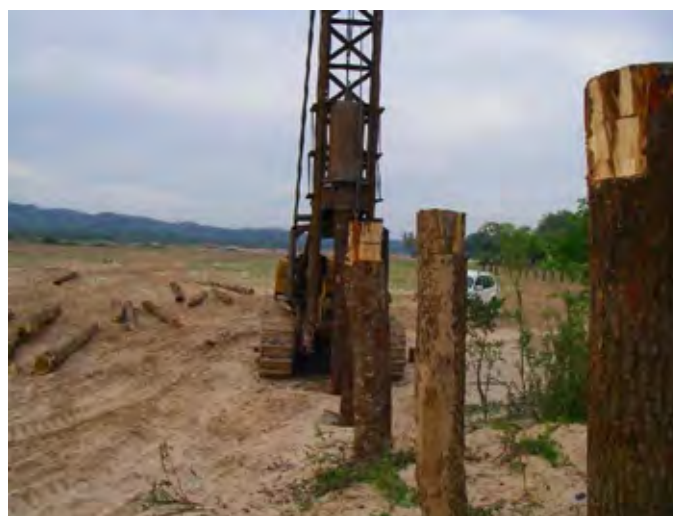
Figura 3-3-17 Martinete para hincado de pilotes
