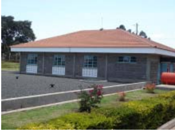
地下浄水池とポンプ棟
