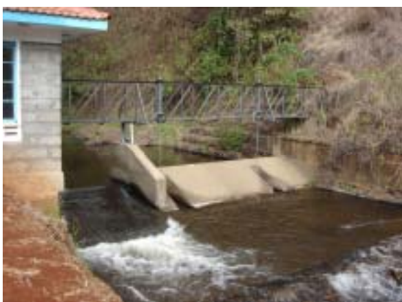
取水場堰と余水吐き
