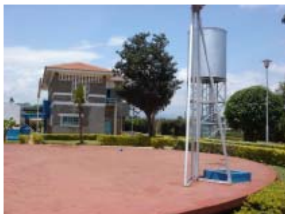
新設流入渠・薬注棟
