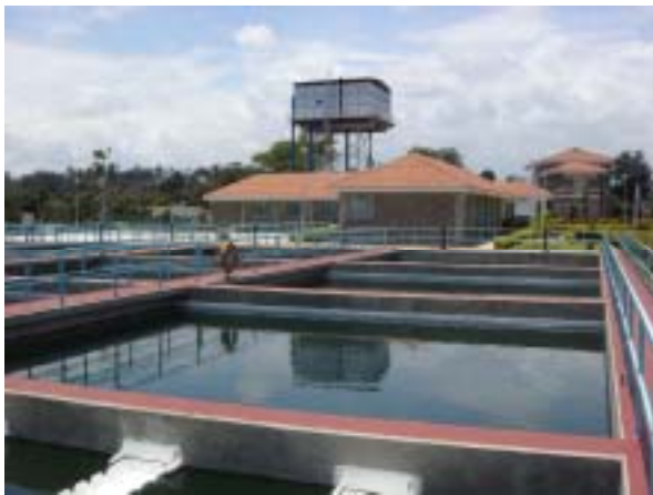
新設薬品沈殿池：フロック沈降性良好
