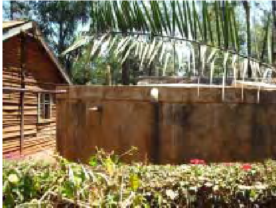
写真 - 7 雨水収集タンク：水道未給水地区では屋根に落ちる雨水をタンクに収集し、生活用水として利用している。
