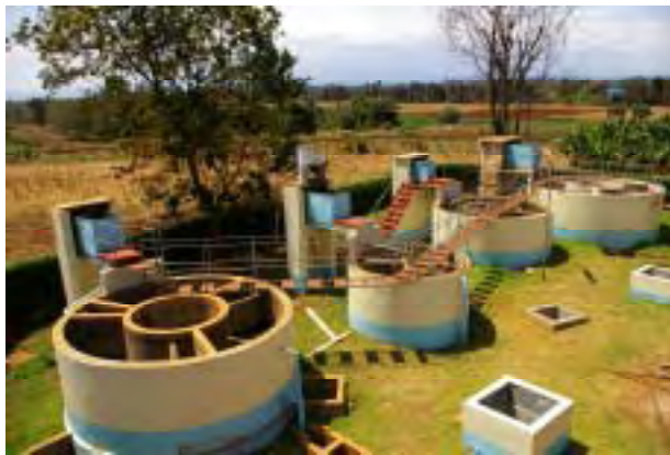
写真 - 5 カンガル浄水場：現在はムカング浄水場からの浄水だけでなく、カピンガジ川からも取水を行い、浄水を行っているが、施設の老朽化は否めない。
