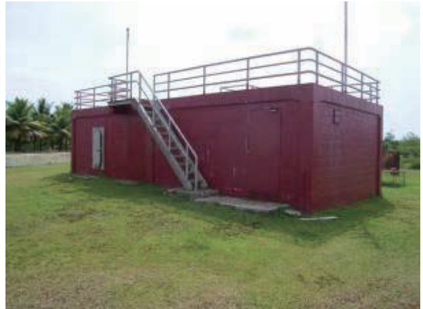
本プロジェクトで建設された消火訓練施設。特に破損箇所はなく、基礎船舶安全訓練で主に用いられている。
