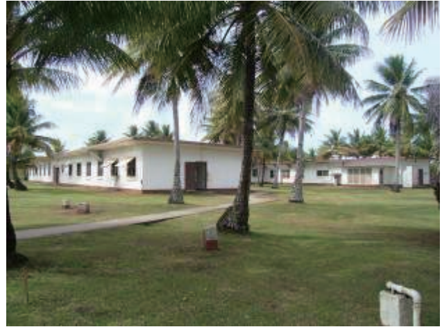
漁業・海事専門学校の学生寮（手前）と管理棟（奥）
