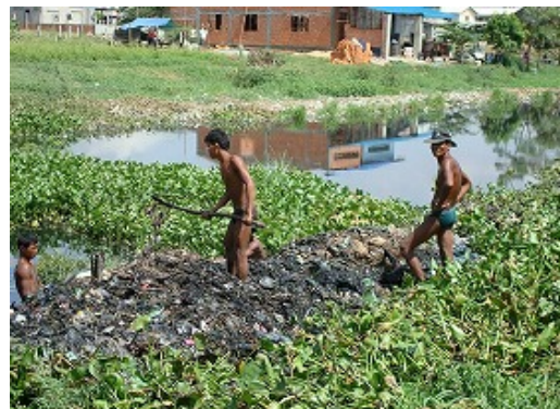
排水路のごみ清掃風景
