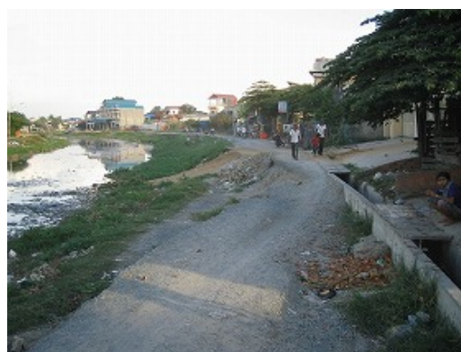
「すべり」が発生した排水路脇の管理道路
