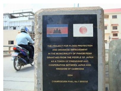
改修したミンチエイ排水路に 架かるチャムルーンパル No.1 橋梁
