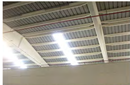
工場診断後：照明効果を高めるために天井を張り替えた
