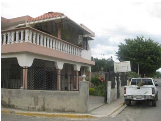
プロジェクト対象地域にあるリオ・ユナ 水利組合連合の事務所
