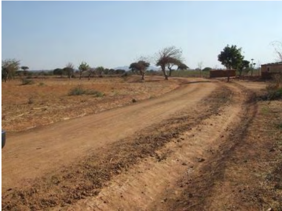
LBTにより建設されたドロマ市近郊の道路 (2009年10月)
