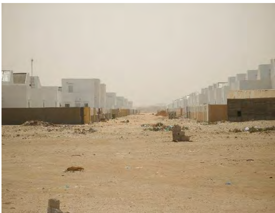
建設中の住宅地
