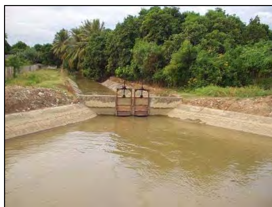
Bê tông kênh và đập nước tưới lúa. Loại hệ thống thủy lợi như trên sẽ được xây dựng là “cơ sở hạ tầng quy mô nhỏ”: tỉnh Ninh Thuận
