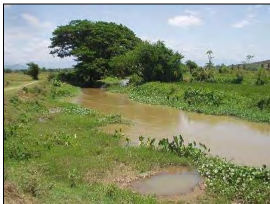
灌漑用の水路：このタイプの水路が補修・建設工事の 対象となる（ニントゥアン省）
