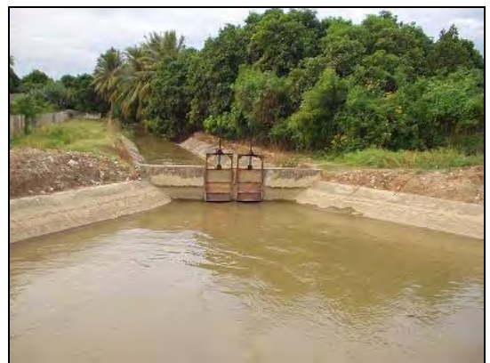
工事後の灌漑水路の例：左写真の現場は、工事後この ように水路が補強される（ニントゥアン省）
