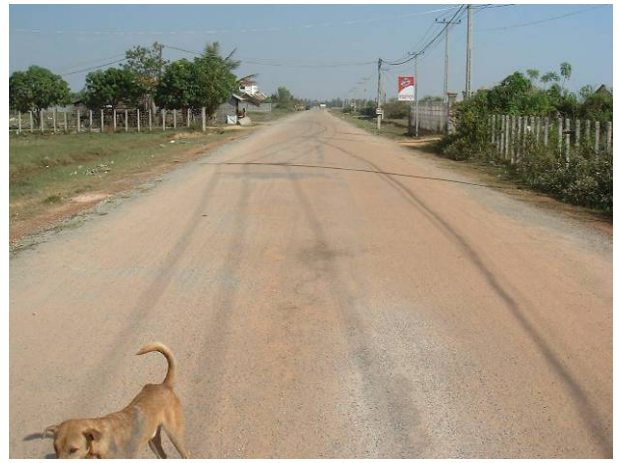
シエムリアップ州 DPWT が 2008 年に実施した州道整備 (DBST)
