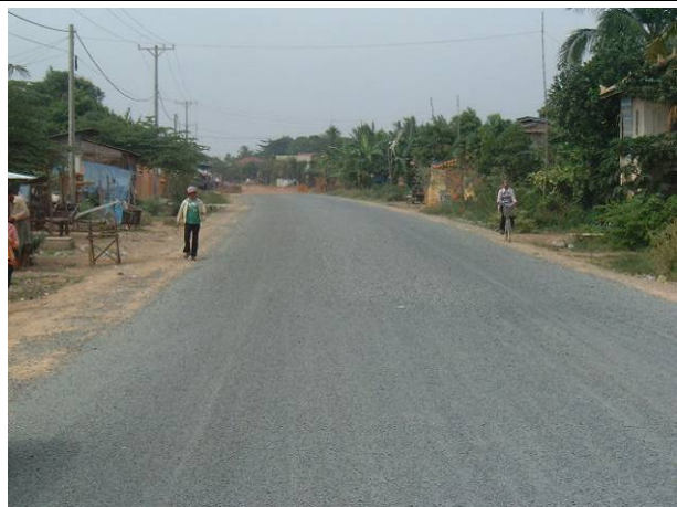
カンダール州 DPWT が 2008 年に実施した国道 21A 号線の改修工事 (DBST)
