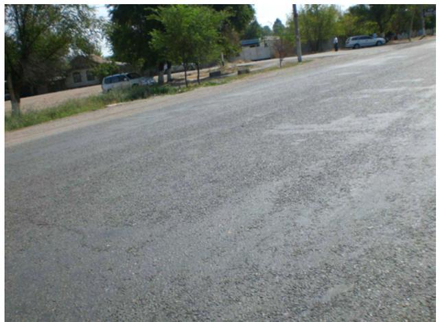
BNT 道路 トクモク付近 チップシールの砕石が飛びアファルトが浮いている。
