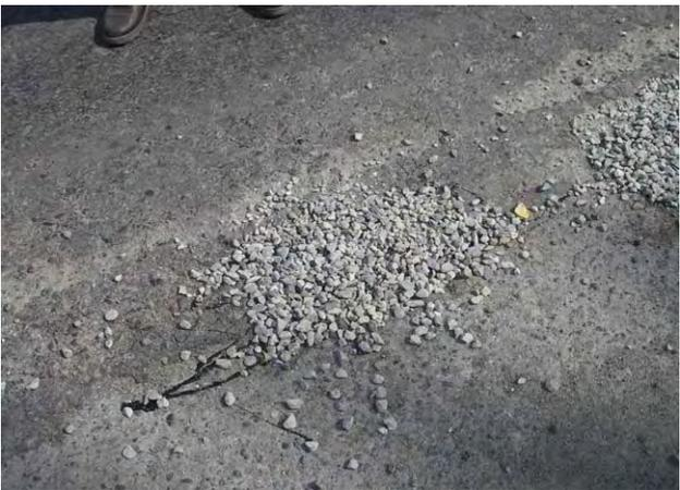
現在のパッチング施工状況 アスファルト材の上に砕石を散布したのみで、すぐに剥離する。
