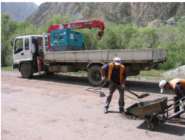
「ナリン建機道路維持管理用機材整備計画」（無償）にて調達された機材を使用したパッチング作業
