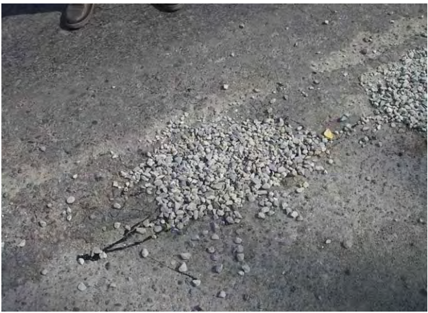
現在のパッチング施工状況 アスファルト材の上に砕石を散布したのみで、すぐに剥離する。
