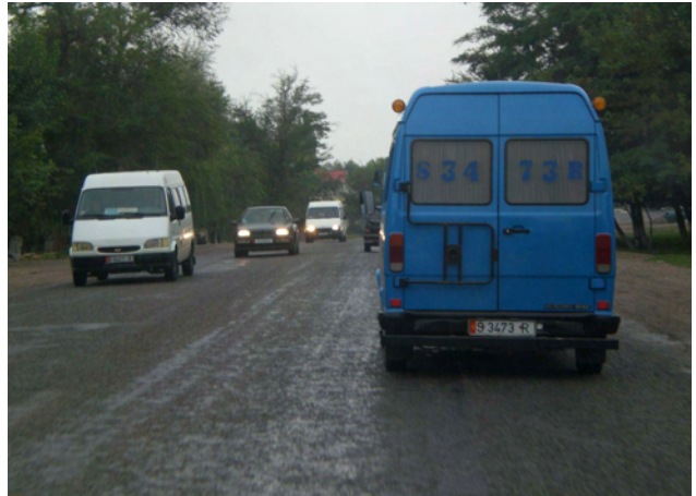
BNT 道路 70km 付近 舗装が古いいため路面が荒れている。
