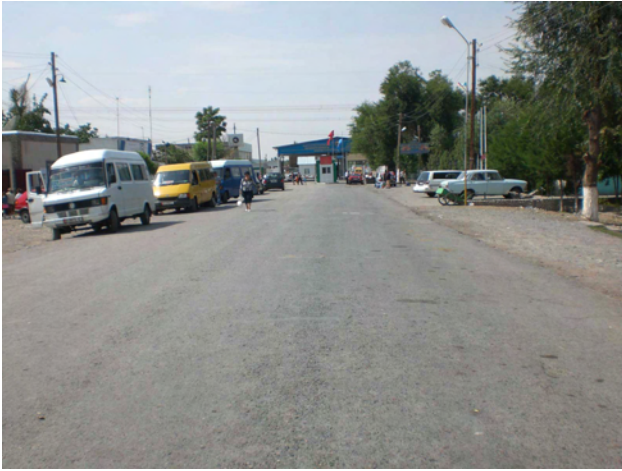
チャルドバル国境手前 シーリング、パッチングなど補修跡が多い。
