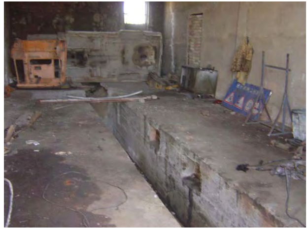
DEP35 機材修理場 修理用機材は溶接機しかない。
