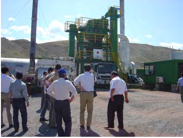
「ナリン建機道路維持管理用機材整備計画」（無償）により設置されたコチコールのアスファルトプラント
