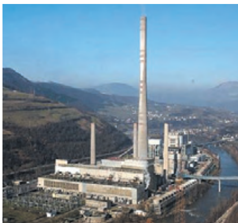
カカニ火力発電所
