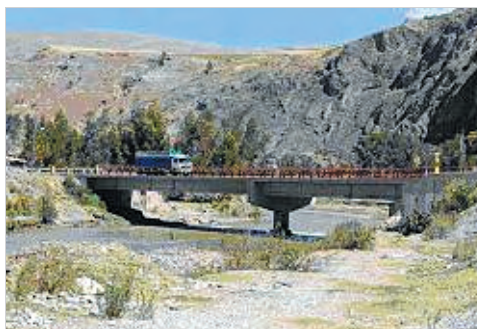
本事業で建設された橋梁（フニン地域）
