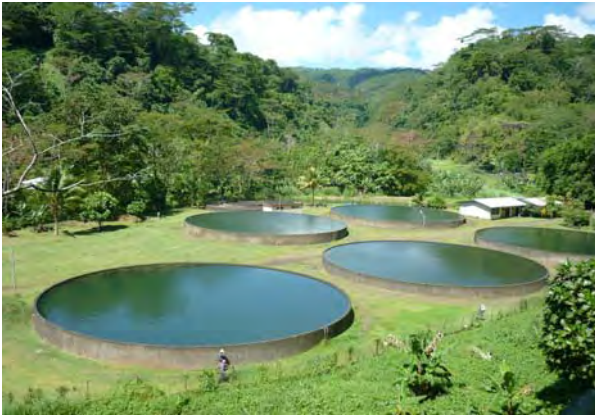
1986年にドイツが施工した円形のろ過池
