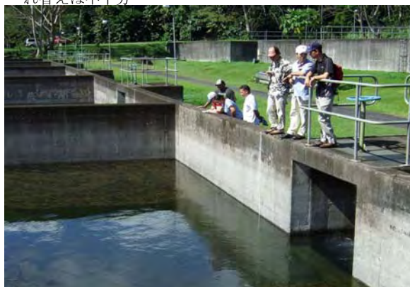
2000年にEUが施工したろ過池 生物浄化が進むよう 水量を少なくしている
