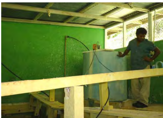
ロベ湧水の塩素滅菌処理場
