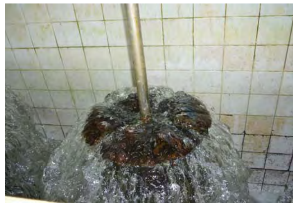
円形ろ過地の水量調整弁
