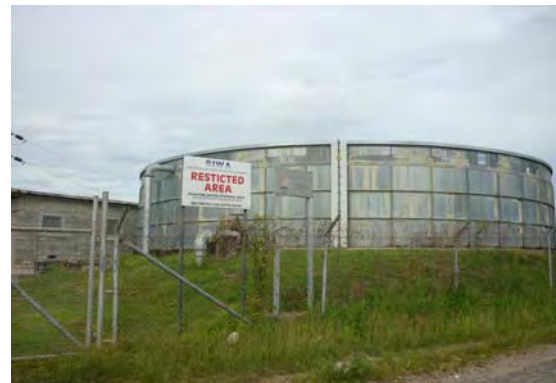
1996年、日本の無償資金協力によるパナティナ配水タンク
