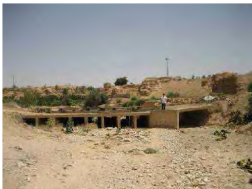
Box Culvert の現況 (下流側)
