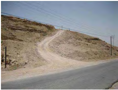
449号より Nueime 方向(表層工と略盤工)
