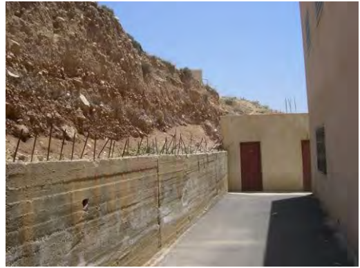
既存建物裏の擁壁
