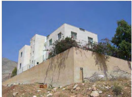
既存建物背面
