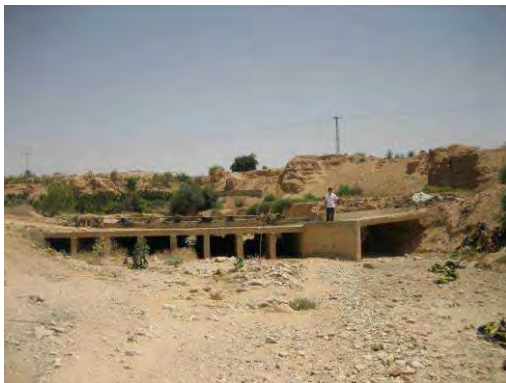
Box Culvert の現況 (下流側)
