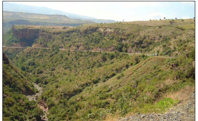
国道3号線アバイ溪谷区間。切土と盛土を繰り返し、山肌を縫うように走る。急峻な谷では、山側、谷側とも用地の余裕がなく、道路1本を通すのが限界であり、難工事であったことが推察できる。
