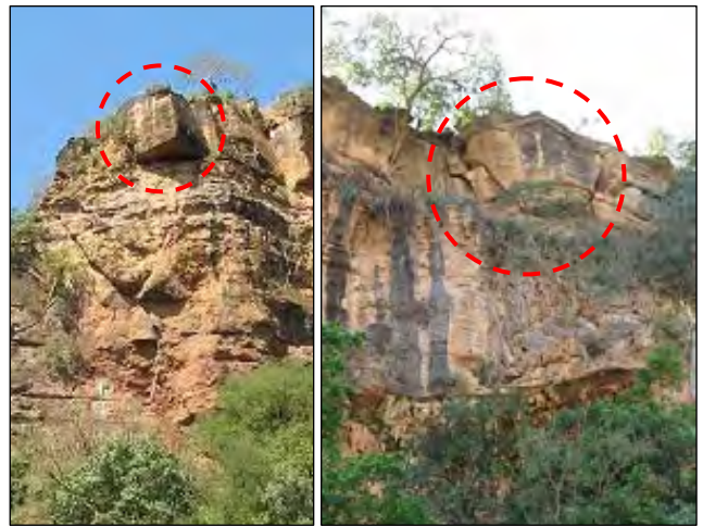
容易に落石の生産源となる頂部にある不安定な巨石。落石を待ち、破碎し、搬出するのが対策。
