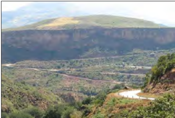
国道3号線アバイ溪谷区間。切土と盛土を繰り返し、山肌を縫うように走る。急峻な谷では、山側、谷側とも用地の余裕がなく、道路1本を通すのが限界であり、難工事であったことが推察できる。
