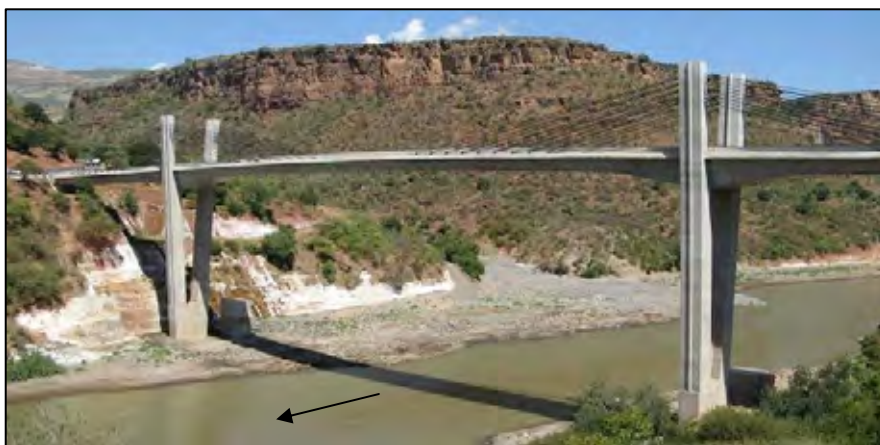
図 2-1-6 アバイ橋（下流側から）
