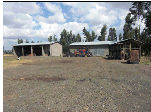
ムケトゥリセクションの施設。 左：ガレージ、中：倉庫、右：給油施設
