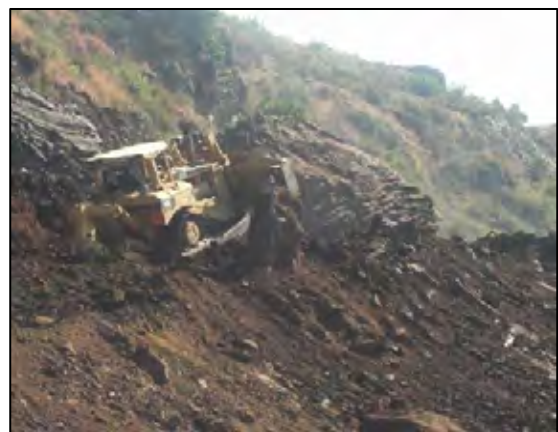
図 1-2-7 ブルドーザと転石
