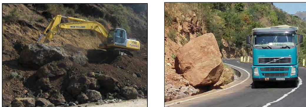
図 1-2-4 掘削土に含まれる巨石（左）、道路わきの巨大転石（右）
