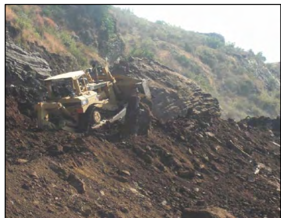
図 1-2-7 ブルドーザと転石
