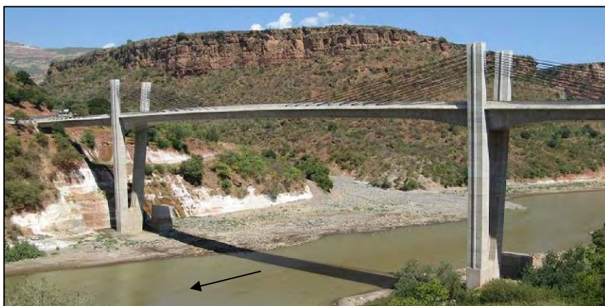
図 2-1-6 アバイ橋（下流側から）
