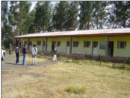
アテムガナ地方道路運営維持請負事務所、ムケトゥリセクションの本部建屋
