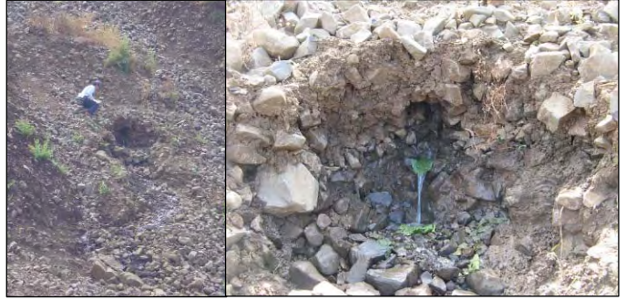
道路山側の斜面から流れ出てくる水、水抜き水平ボーリングの対象である。
