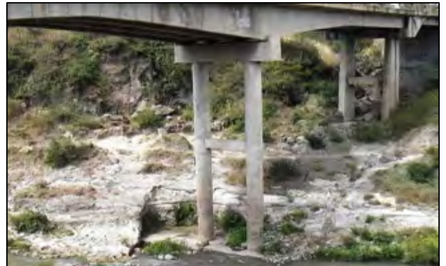
写真6：非常に細い橋脚柱
