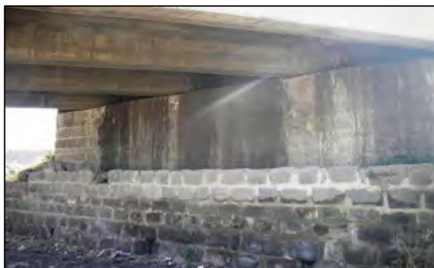
写真5：老朽化の進む橋台
