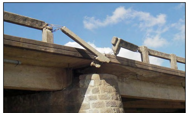
写真6：車両の衝突により損傷した高欄
