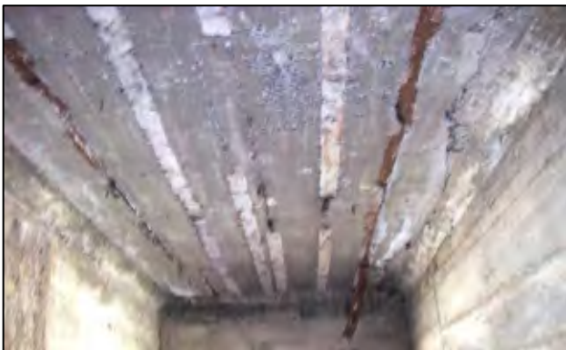
写真3：腐食の著しい床版下面
