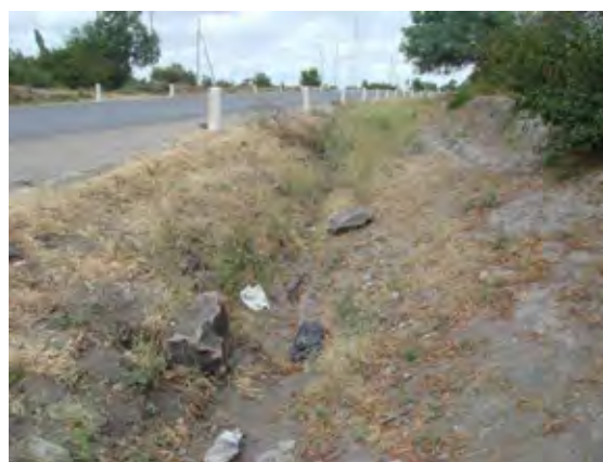
写真2-17: 曲線内側に素掘り側溝が設置されている。
