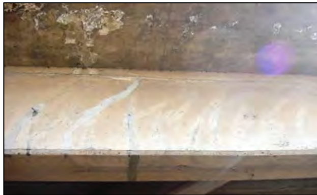
写真3：せん断ひび割れが生じている主桁
