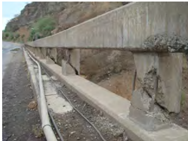
写真 2-19: アワシユ橋の高欄が事故により破損している。
