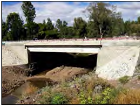
写真 2-3 デュケム橋 (全景)
