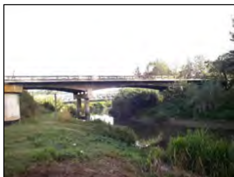
写真 2-6 アカキ橋（全景）
