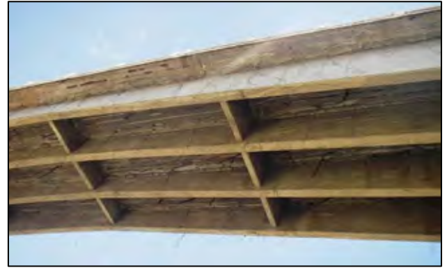
写真4：非常に薄い主桁フランジ幅
