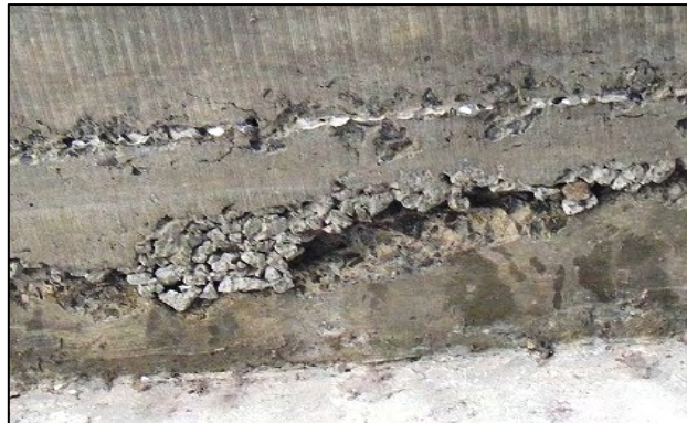
写真5：施工不良により生じたジャンカ（豆板）
