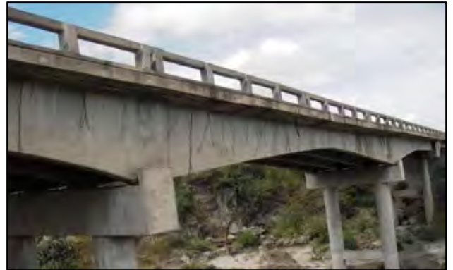
写真2：せん断ひび割れが生じている主桁
