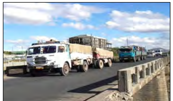
写真8：大型車両による振動が激しいゴゲチャ橋
