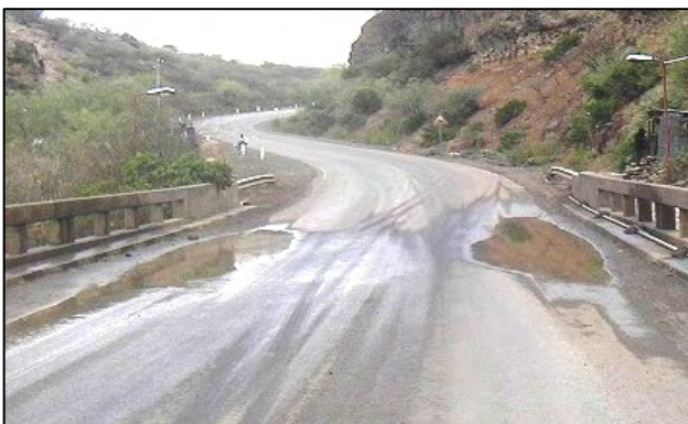
写真7：凹んだ橋面に溜まった水
