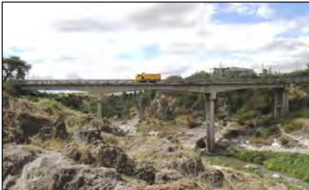
写真1：モジヨ橋全景（側面）
