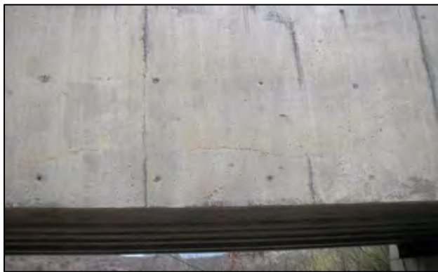
写真5：ひび割れの見られる主桁部
