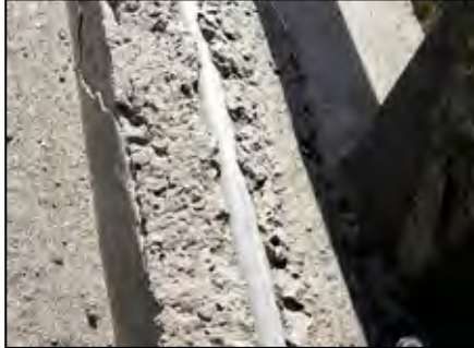
写真 10 : 地覆に添加されている水道管
