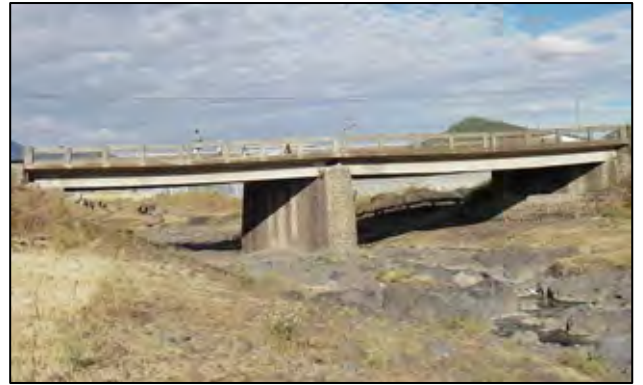
写真2：下に撓んでいる主桁
