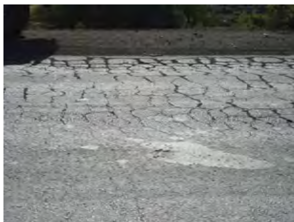
写真 2-1 4: ゴゲチャ橋付近の舗装。ひび割れが観察される。
