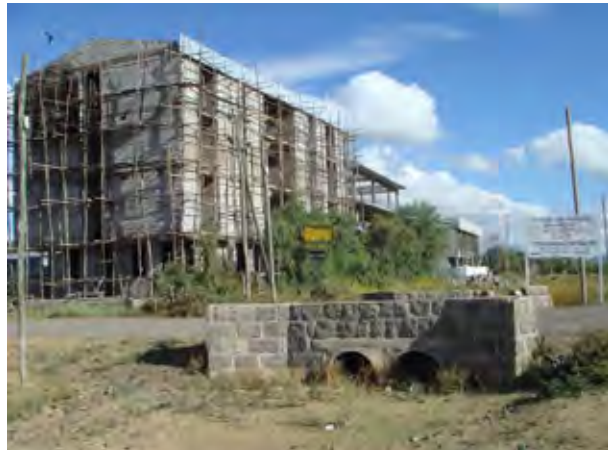
写真 2-1 5: ゴゲチャ橋の南東側 70 m 付近の取付道路。建設中の建物と排水カルバート。
