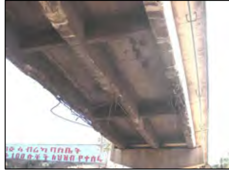
写真 2-10 国道 1 号線上の跨道橋（全景） 写真 2-11 車両の衝突により損壊している主桁
