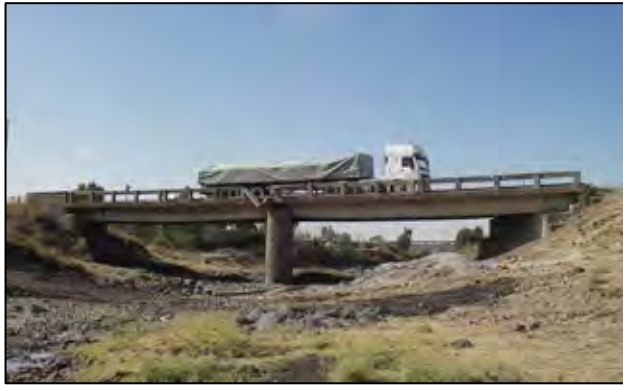
写真1：ゴゲチャ橋全景（側面）
