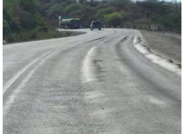
写真 2-21: 著しい舗装の損傷（アワシユ橋の西側の急勾配区間）。
