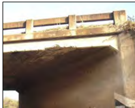
写真 2-9 車両の衝突により損傷した上床版
