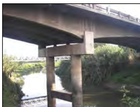
写真 2-7 非常に細い橋脚
