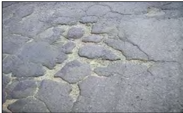
写真7：ひび割れ、損傷の著しい舗装面
