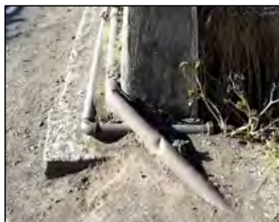
写真4：水道管と通信管
