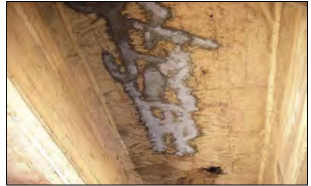
写真4：床版下面に生じているひび割れ及び補修跡
