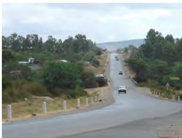
写真2-16: モジヨ橋付近がサグになっている（北西側（アディスアベバ側）より撮影）。
