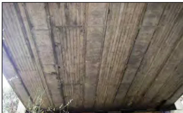
写真3：腐食の著しい床版下面
