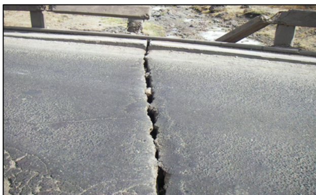
写真7：空間が生じている伸縮継手部
