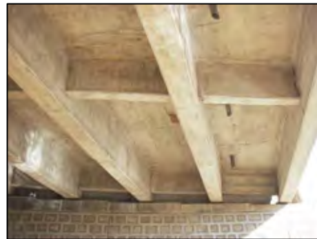
写真 2-4 デュケム橋の主桁と床版
