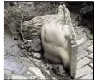
写真6：車両の衝突により落下したモニュメント
