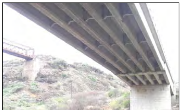
写真4：非常に薄い主桁フランジ幅
