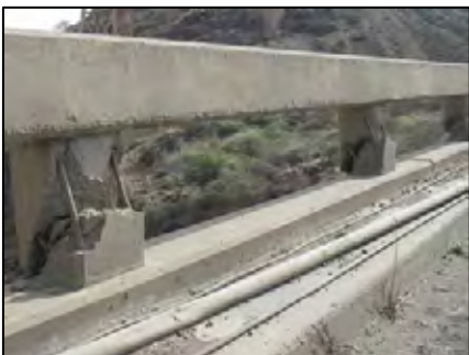
写真 15 : 水道管と電気ケーブル
