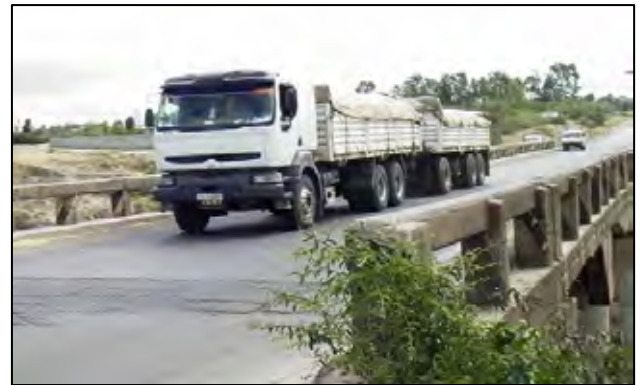
写真8：大型車両により大きく揺れるモジヨ橋
