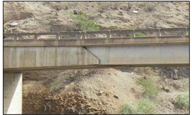
写真2：機能不全と思われるゲルバー桁ヒンジ部
