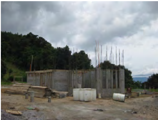
トニカパン市「道の駅」建設現場
