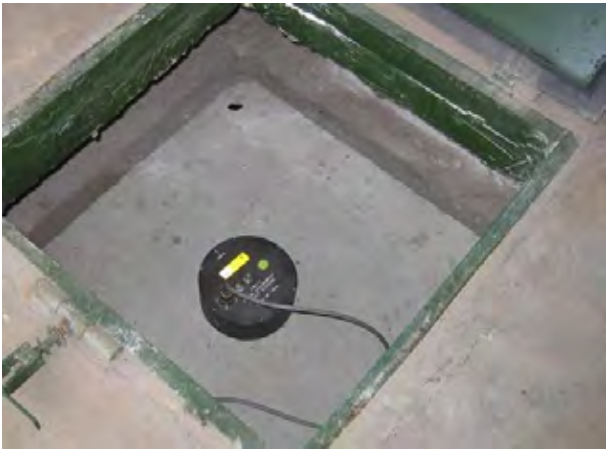
テヘラン市内の10箇所に設置した地震計本体 (本プロジェクト供与機材)
