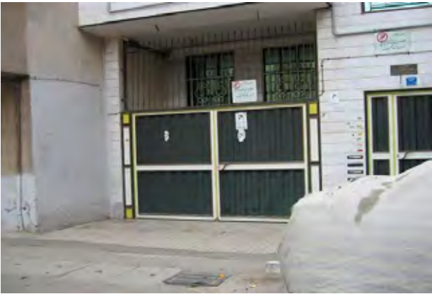
JICA の開発調査で最も倒壊家屋が多いと推定された 17 区が、自主的に進めているセットバック事業により、1 階を後退させた住宅
