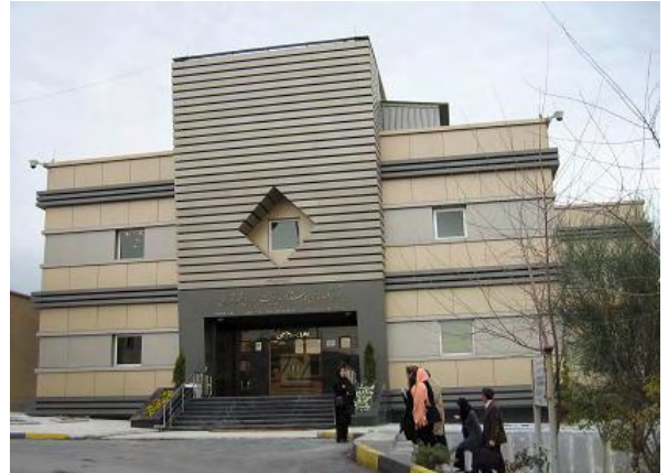
2009年12月に竣工した緊急対応指令センター (ERCC) (TDMMOの管轄下)
