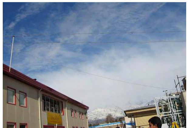
災害対応管理センターに地震計から観測データを伝送する ライン。大規模な震災時には切断の可能性もあり、無線 通信等の導入を検討中
