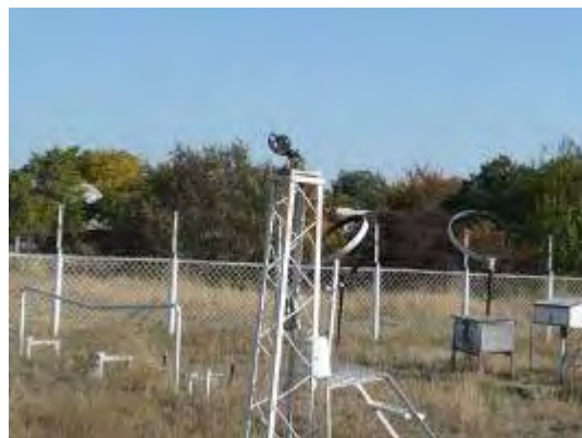
写真 2-2-17 自動気象観測機器エリア（部分）
