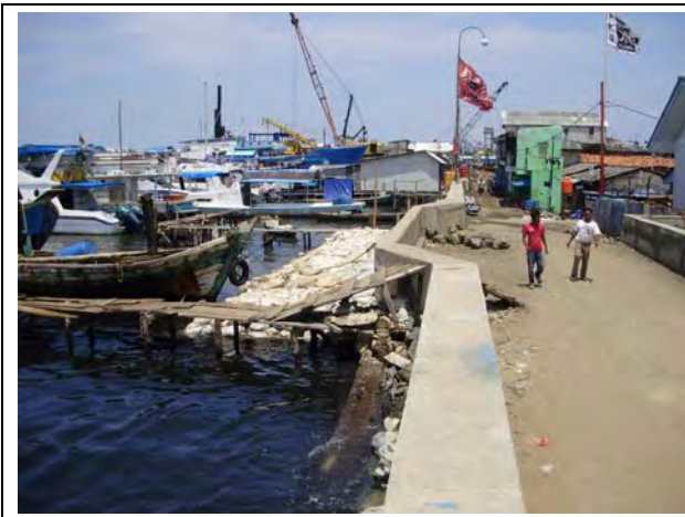
写真-2.12 海との遮断工
