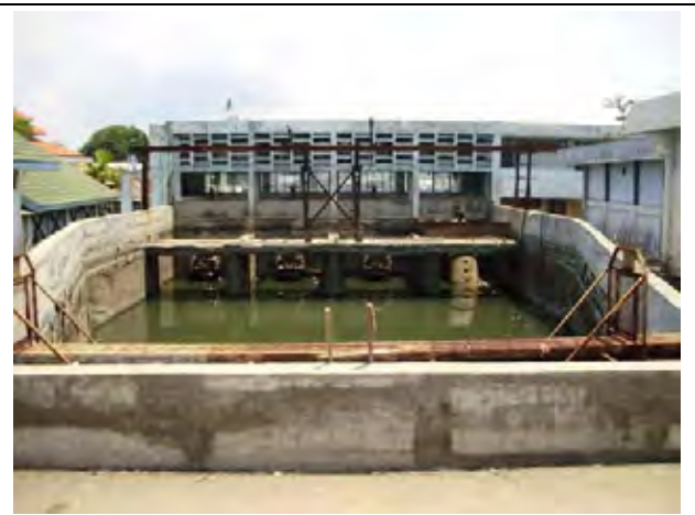
写真-2.13 吐き出し口水槽の状況 (22-2-09)
