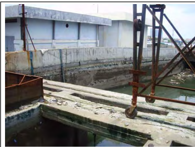
写真-2.14 左壁の状況(1)
