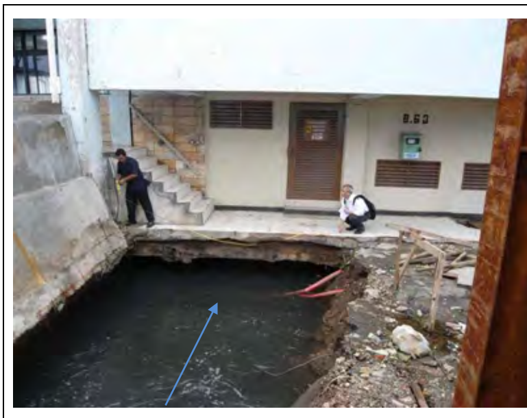
写真-2.10 ポンプ場底部へのパイピングルート入り口
