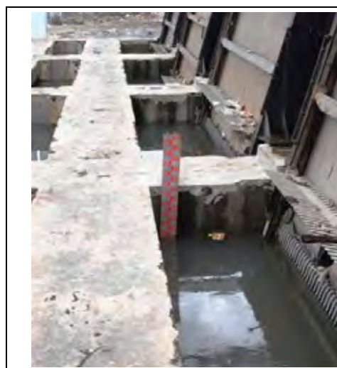
写真-2.4 ポンプ場入り口の水位標
