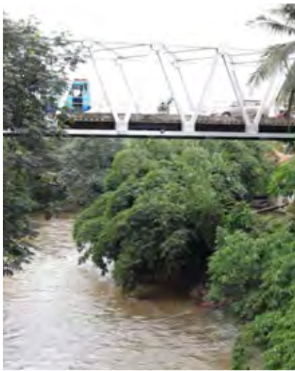
写真-2.23 上流の橋での水位測定
