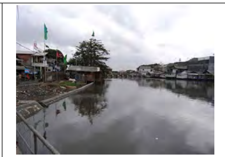
写真-2.5 ポンプ場前の調節池（フォアベイ）の状況
