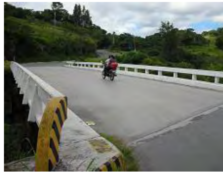
エル・チャト橋
