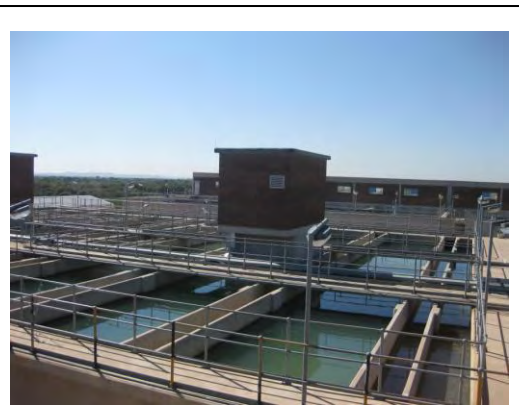
ママシア浄水場
