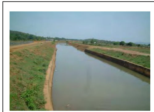
事業で整備された主用水路
