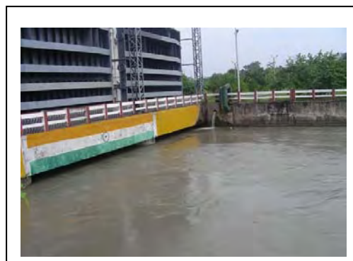
用水路下流から見た発電所
