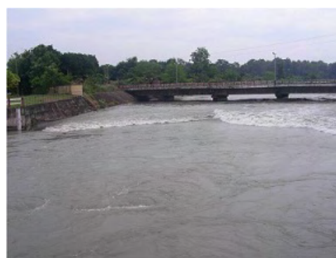
図 2 放水口の現状(反対側)
