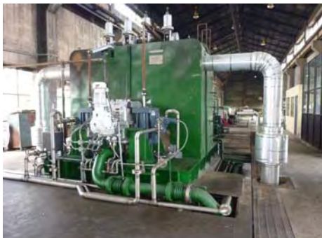
図 6：修理後のガス・コンプレッサー
