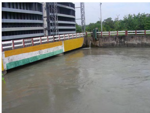
図 1 放水口の現状(1 基稼働時)
