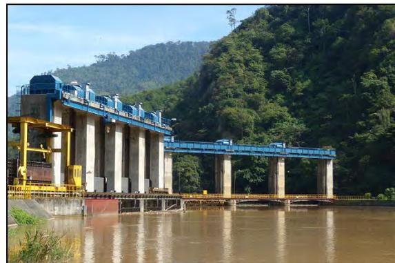
テノンパンギ水力発電所の取水口
