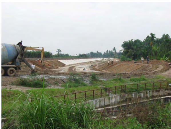
建設中のウラル地区灌漑用導水路
