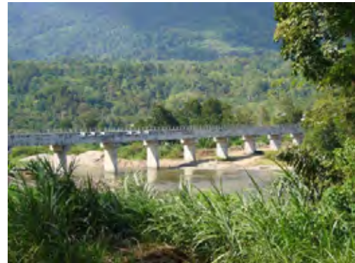
バタンアンゴラ水路橋
