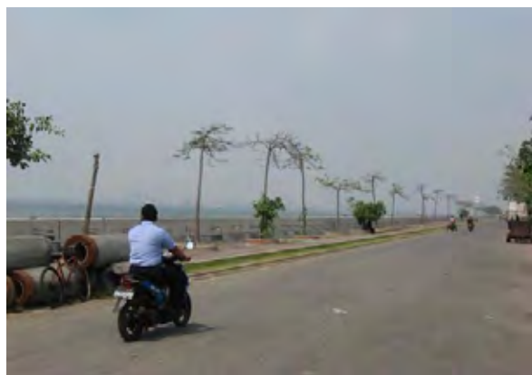
ほぼ完成した東護岸嵩上げ（2009年7月）
