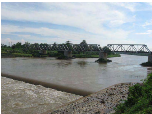
ブランタス川橋梁下流の床止め
