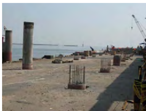
岸壁嵩上げ工事
