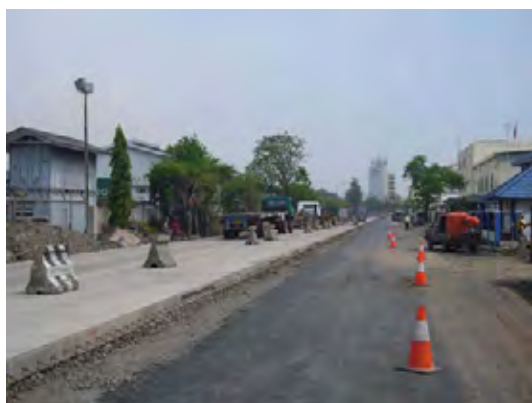
港湾敷地内道路の改良工事
