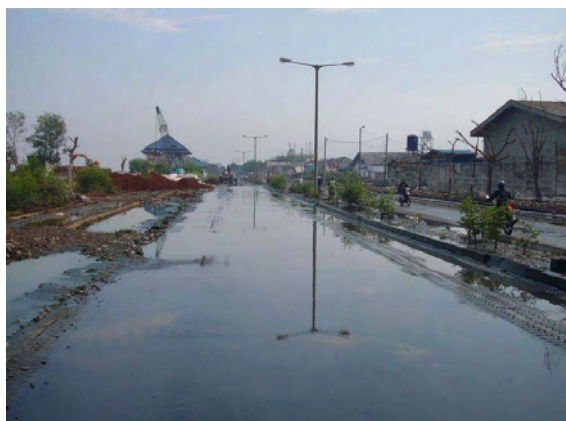
漁港内浸水状況（2009 年 5 月）
