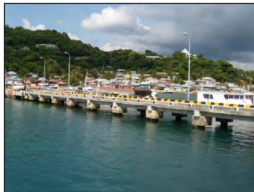
Photo 3 Jetty (Labuan Bajo port)
