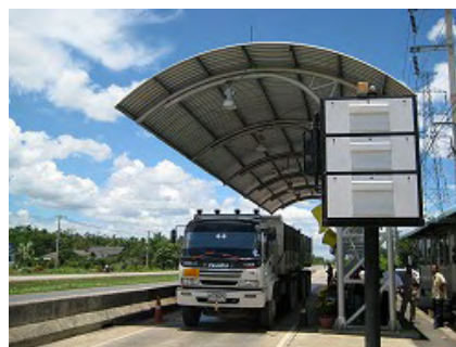
国道 401 号線のドンサック・ジャンクシジョンに設置されている計量場
