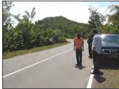
写真1 ムアラエニム～メラピ間
