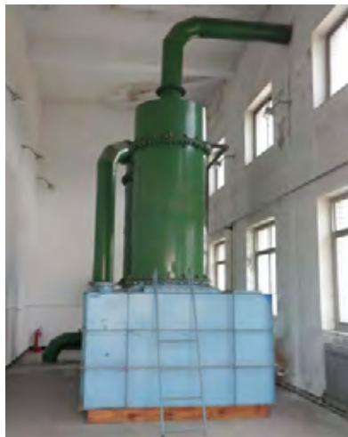
遷西県自来水公司の 本事業により整備された塩素投入機
