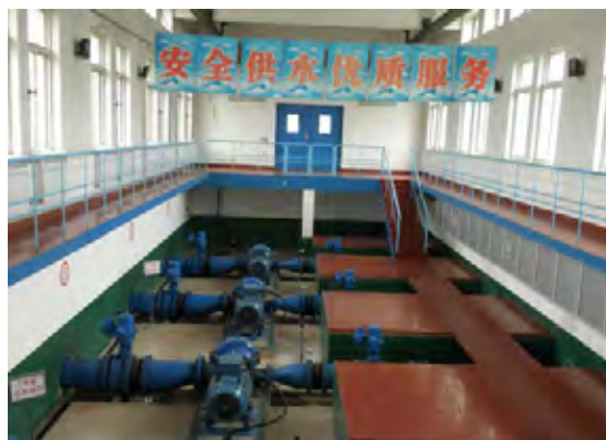
遷安県配水場
