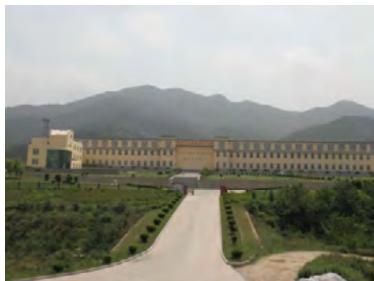
揚家店浄水場
