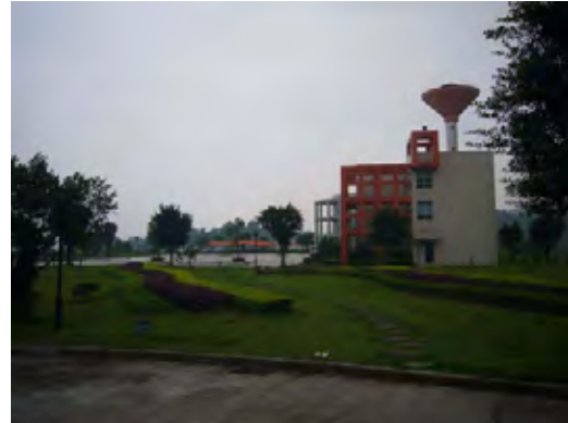
豊収壩浄水場
