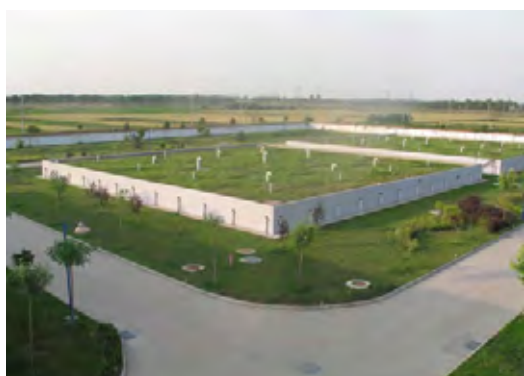
瀾南県自来水公司の本事業により整備された貯水池
