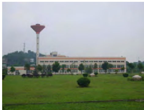
豊収壩浄水場内 貯水池（地下）
