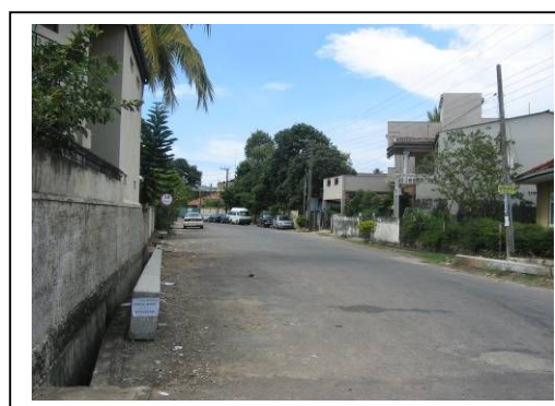
本事業により地下排水路が整備され 浸水被害が大幅に減少した。(同左)
