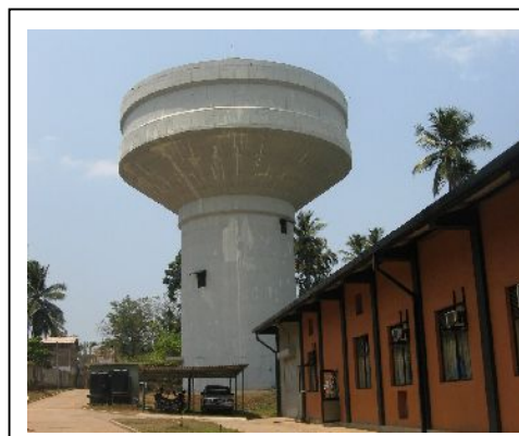
マハラ配水センターの給水塔とポンプハウス
