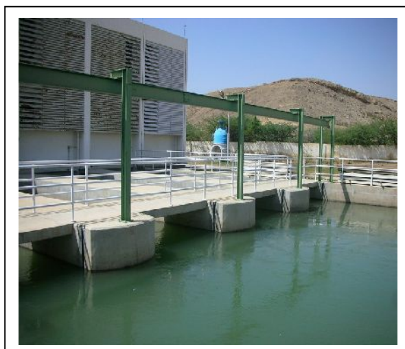
マンゴーピルポンプ場
