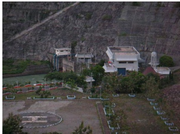
ウォノレジョ水力発電所遠景
