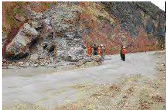
岩石崩壊の撤去作業 (Jauja-Tarma 道路)
