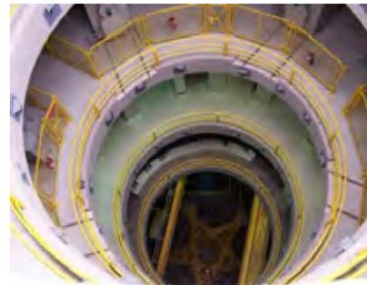
図2 ポンプ場内部 (最深部にポンプユニット配置)
