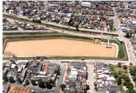
図7 雨水流出抑制施設（調整池）
