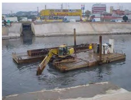
図 17 沈泥除去作業の様子
