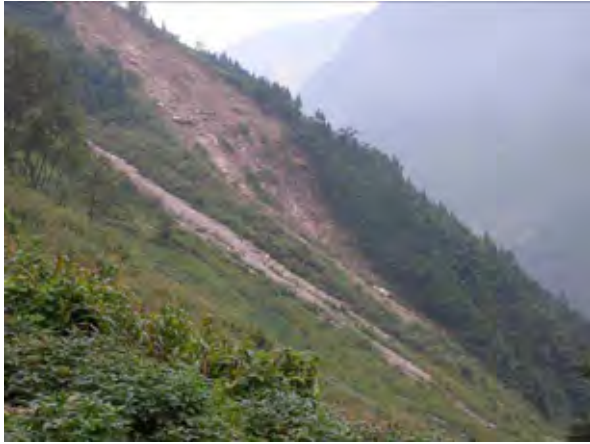
下流部左岸に発生した二つの崩壊地
