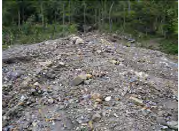
現在も降雨により土砂が下方に流出している
