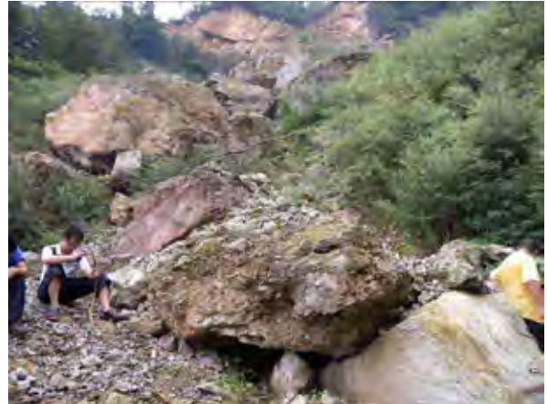
崩壊の発生源と崩落した巨石
