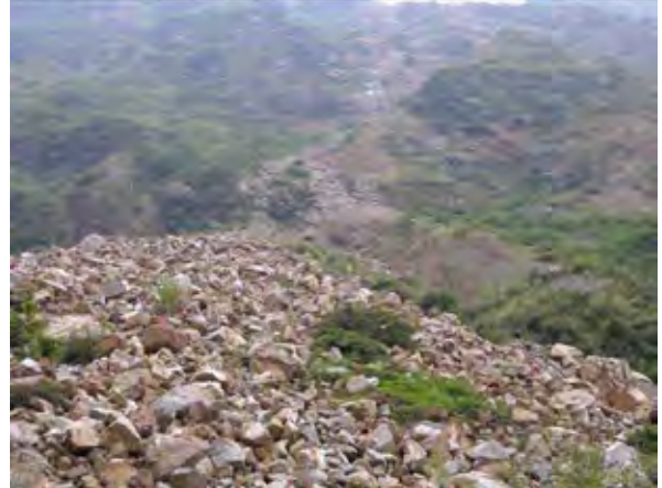
斜面に向かって左側で崩落・堆積した石礫
