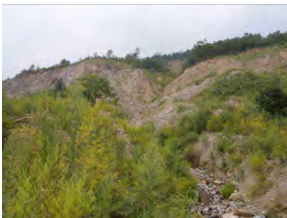
崩壊下部から見た崩壊中央上部及び浸食溝の状況
