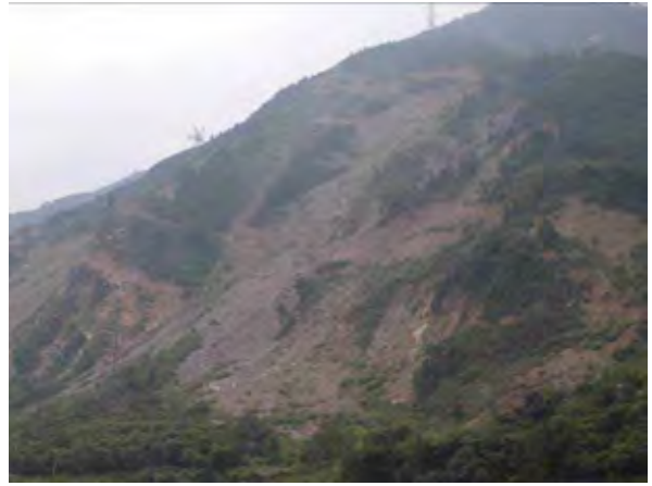
向かって右側の崩壊地
