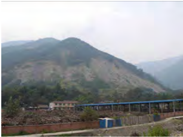
対岸の道路から見た崩壊の全景
