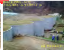
鋼製谷止工の施工
