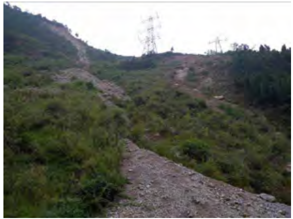
下流部左岸に発生した二つの崩壊地と 溪流に流出した土砂
