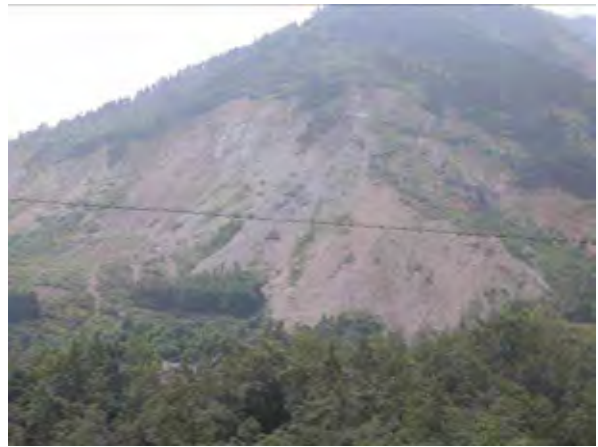
対岸の道路から見た崩壊から向かって右側の状況
