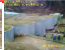
进行钢制防砂坝施工
