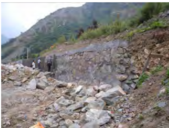
崩壊の下方部（银杏小学校の裏手）で 現在施工中の練石積土留工
