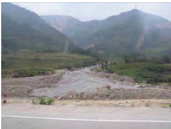
付近の溪流から流出した土砂
