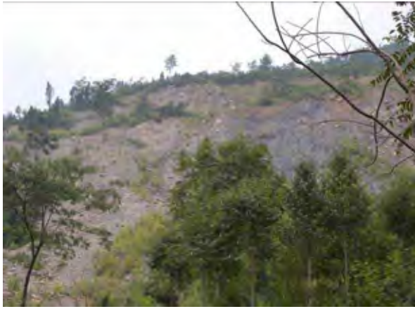
崩壊下部から見た崩壊から向かって左側の状況
