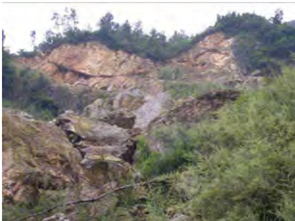
崩壊の発生源 (岩盤が崩落し巨石が堆積している)
