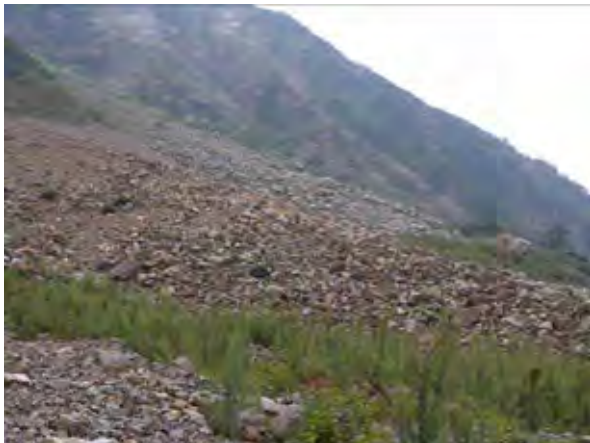
崩壊の下部で崩落した土砂礫が堆積している
