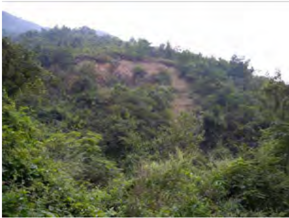
中流部左岸の崩壊地
