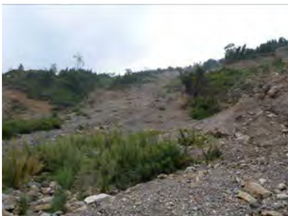
向かって左側の上部の状況
