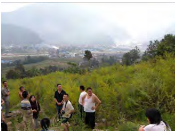
崩壊地からみた下方の播鼓鎮の状況
