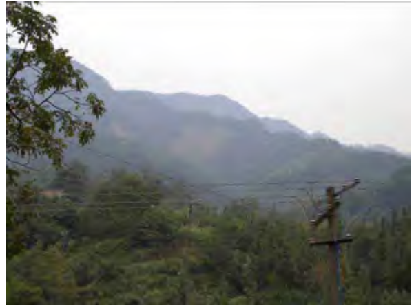
崩壊のある沢の中流部左岸の山腹崩壊
