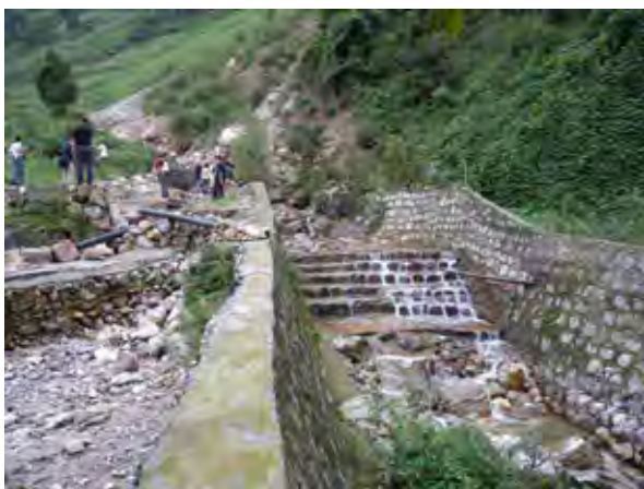
溪流出口付近に作られた練積護岸と水路の施設
