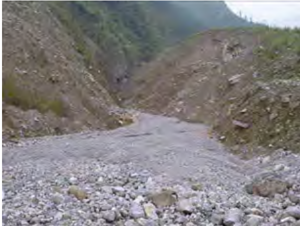
右岸部で谷を形作っている状態。 上部では現在も表土の崩落がある。
