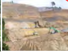
对所有斜坡通过护坡工程加固
