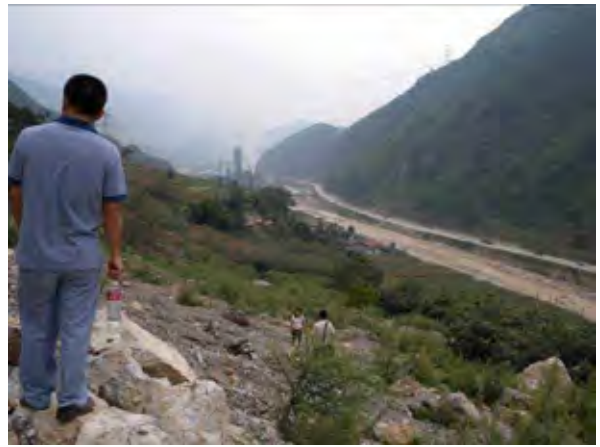
崩壊地からみた下方部の状況 (セメント工場、畑、川、道路)
