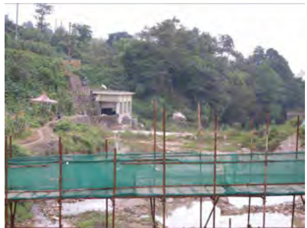
崩壊のある沢の出口にある水利施設
