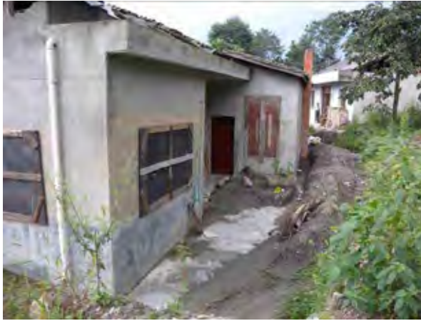
崩落した土砂は家の窓の上部まで堆積した
