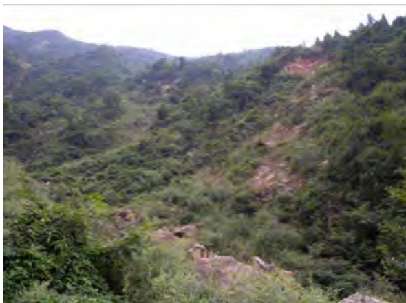
上流左岸支流の崩壊地
