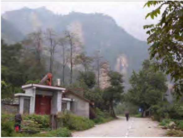
右隣の山の斜面の崩壊状況
