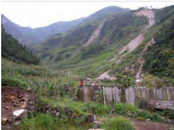
溪流の下流部と左岸に発生した崩壊地の状況
