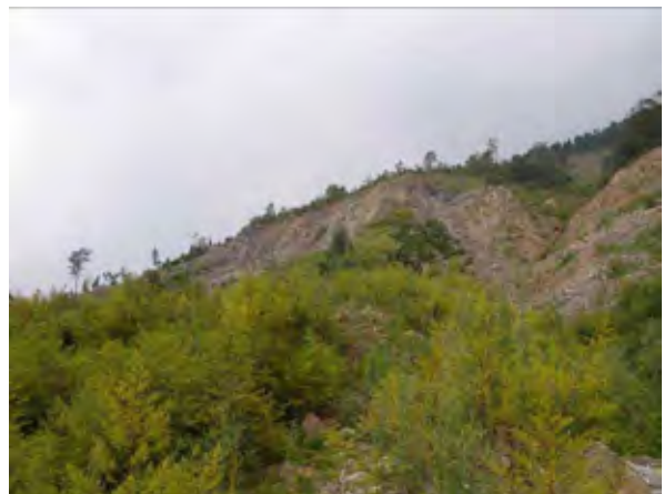
崩壊下部から見た崩壊左側の状況
