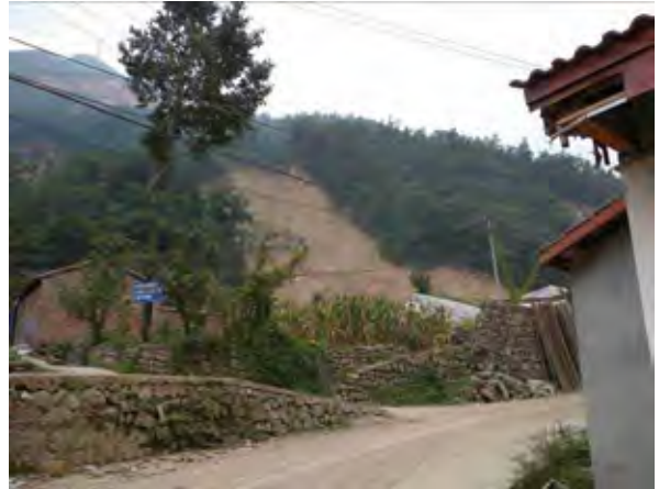
付近の崩壊の状況
