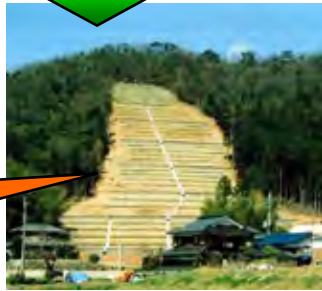
山腹工により復旧
