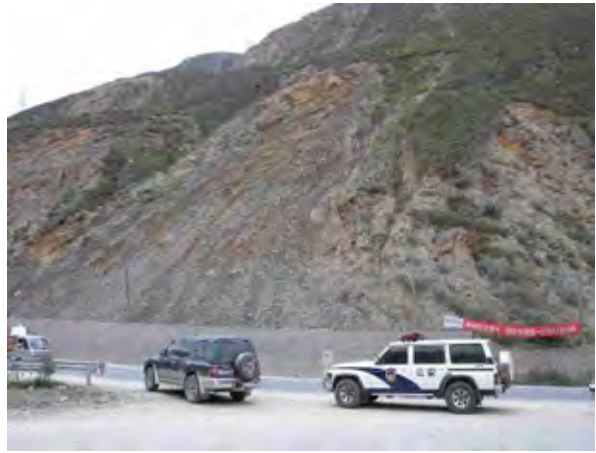
向かって右側の崩壊地
