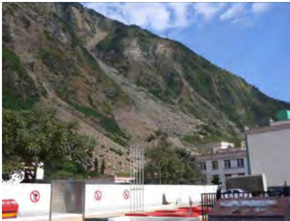
下部のガソリンスタンドから見た崩壊地の全景
