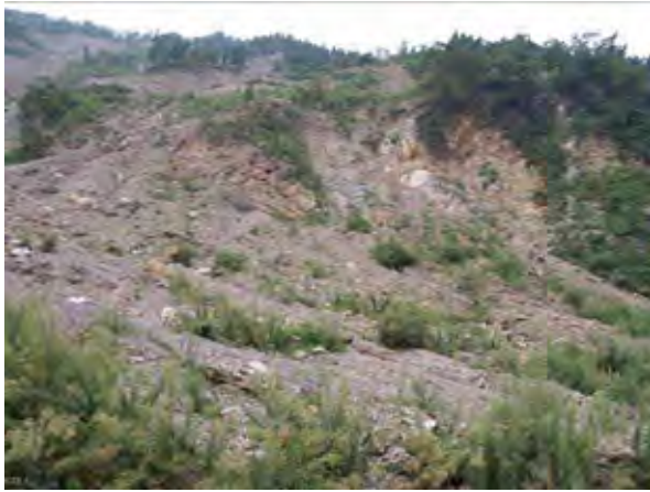
向って右側の上部の状況
