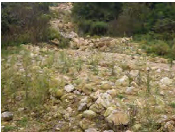
流出した土砂に植生が侵入した状況
