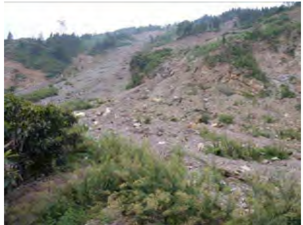
崩壊下部から見た右側崩壊地上部の状況
