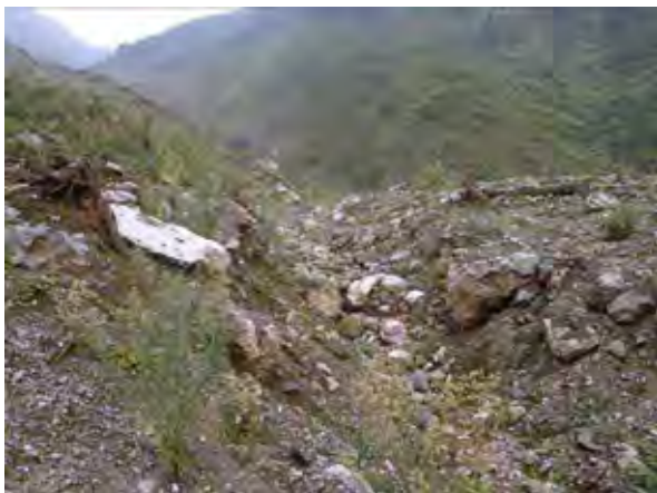
左岸部の状態。
