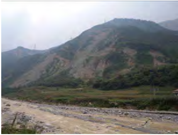
対岸から見た崩壊地全景
