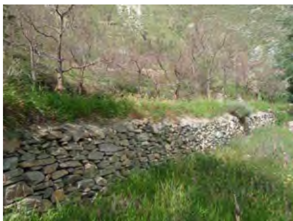
割石空積土留工
