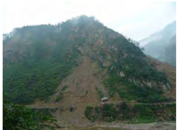
8/22 綿竹市斜面崩壊状況
