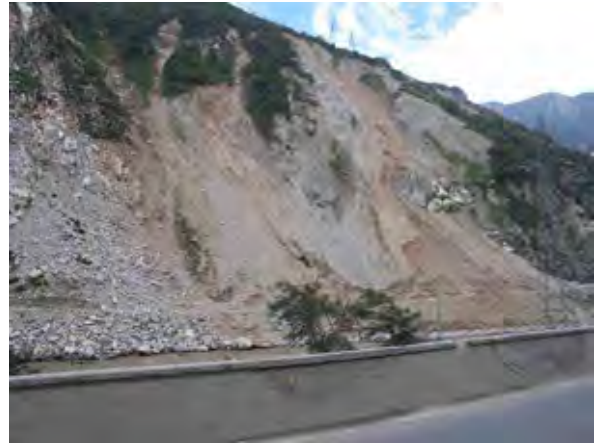
岷江右岸の崩壊状況
