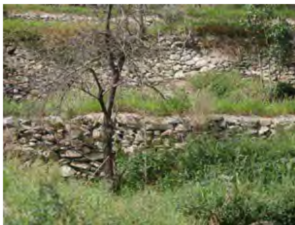
空石積土留工
