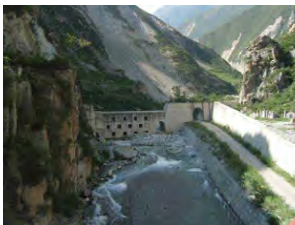
岷江支流出口の構造物
