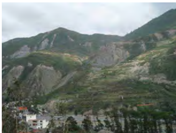
汶川県庁上流側の斜面利用
