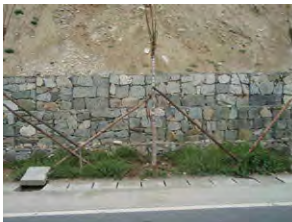
割石布団籠土留工
