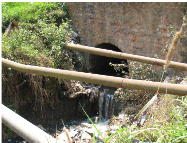
写真 3-2-3 既存レンガ製アーチ渡河構造物
