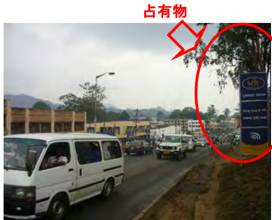
STA 63+00付近(下り線側) 道路用地内に、看板などの占有物がある。 看板後方に見える街路樹3本も道路用地を 占有している。
