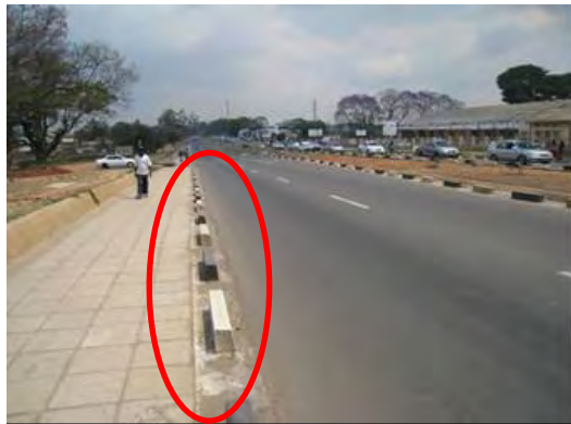
1期工事完了区間 歩車道境界の縁石はフラット型を使用している。 2期工事については、「マ」国からマウンドアップ 型への変更要請がある。
