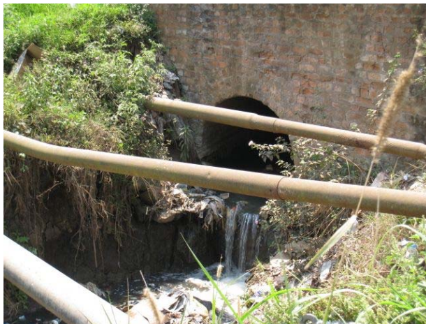
写真 3-2-3 既存レンガ製アーチ渡河構造物
