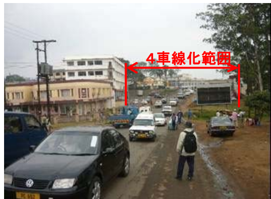
STA 65+00付近 左写真の箇所など一部区間を除いて、4車線化のための道路用地は確保済みである。
