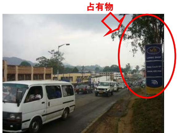
STA 63+00付近(下り線側) 道路用地内に、看板などの占有物がある。看板後方に見える街路樹3本も道路用地を占有している。
