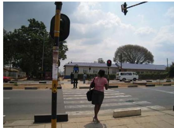
写真 3-2-5 新規型横断歩道 1期工事で採用した幅員3mの横断歩道で 運転手からの視野が高くなった。
