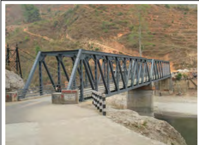
写真-11：道路局によってドラルガット付近に建設された1 車線のトラス橋、支間長 45m2連、本プロジェクトで同様の 形式の橋を6箇所建設する計画である。
