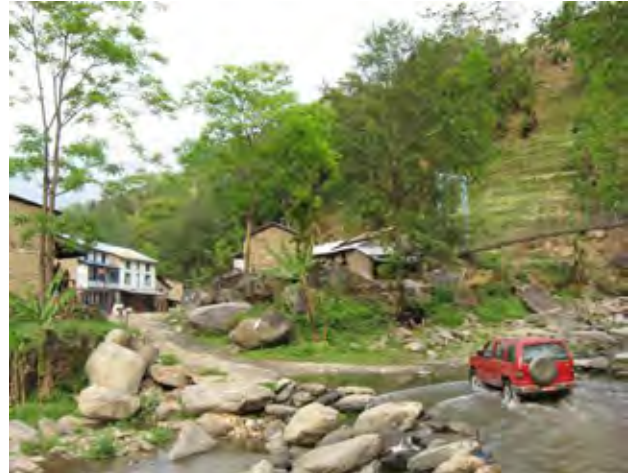
写真-2：シンドウパルチョーク郡、路線 No.13 メラムチーボタン道路、サイト No.13-6、乾期終盤 2009 年 4 月撮影 雨期には通行できない。
