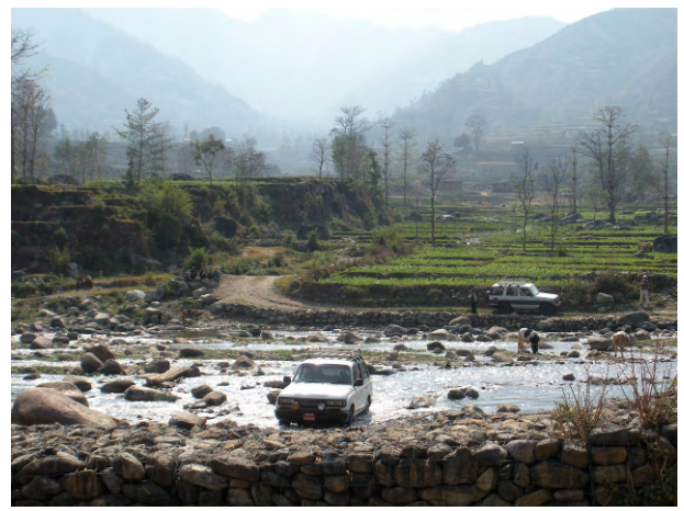
写真-4：カブレパランチョーク郡、路線 No.9 カブレバジャング-ダプチャーカカレ道路、サイト No.9-1、乾期終盤 2009 年 4 月撮影、雨期には通行できない。
