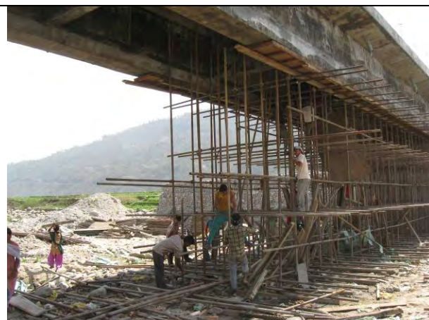
写真-10：道路局によってメラムチ付近で建設中の支間長28m、1車線の鉄筋コンクリート橋、本プロジェクトで同様の形式の橋を3箇所建設する計画である。
