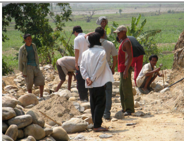
写真-8：シンズリ郡、路線 No.2 シンズリマディーカプリコット道路、スイスの援助で地方開発委員会が実施中の道路改良工事、建設機械は一切使われていない。
