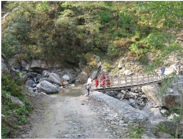
写真-3：ラメチャップ郡、路線 No.8 ベタリーキムティ道路、サイト No.8-1、乾期終盤 2009 年 4 月撮影、急流で雨期の渡河は危険である。
