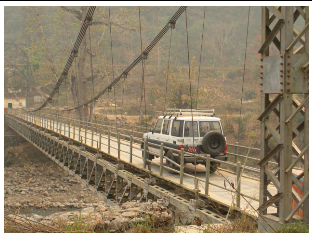
写真-12：道路局によってポカラに向かう道路沿いに建設された1車線の吊橋、支間長100m、本プロジェクトで同様の形式の橋を3箇所建設する計画である。
