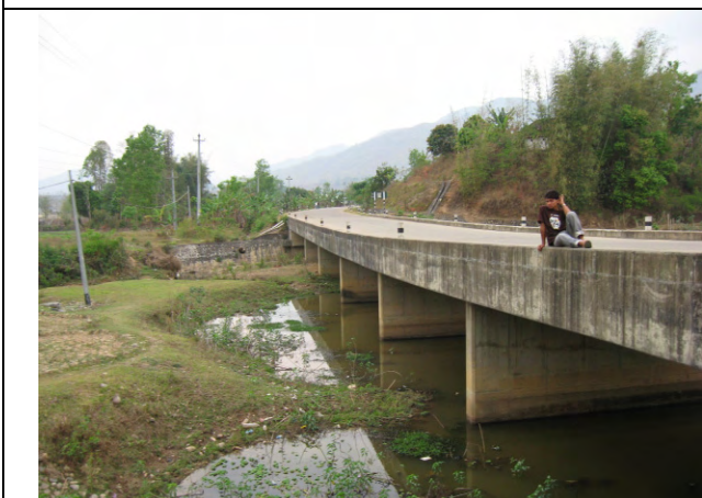
写真-9：シンズリ道路第2工区建設事業で建設された連続ボックス橋、本プロジェクトで同様の形式の橋を23箇所建設する計画である。
