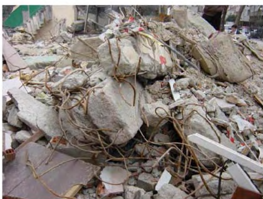
(3) 柱はやや扁平な矩形断面で主筋は丸鋼を使用、柱フープ筋は確認できない（3月9日撮影）。
