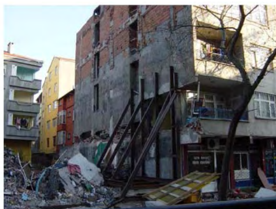
(2) 隣接建物（1、2階柱が変形しており、鉄骨のサポートで仮補強している）
