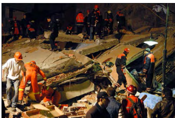
(1) 倒壊建物全景
