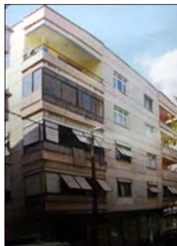
(4) 倒壊前と見られる建物
