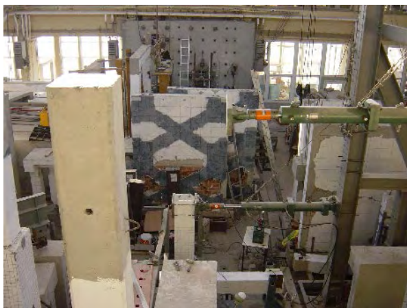
(1) 構造実験室の内部その 1
