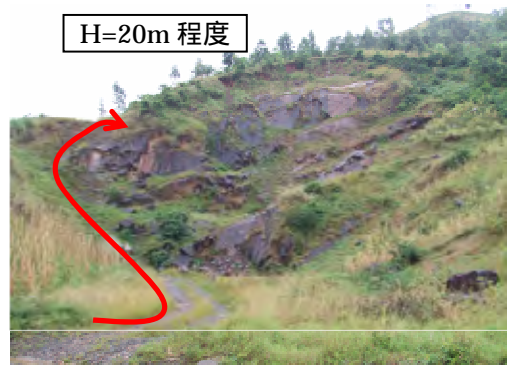
図 3-2-4-6.1 国道に近接する原石山
