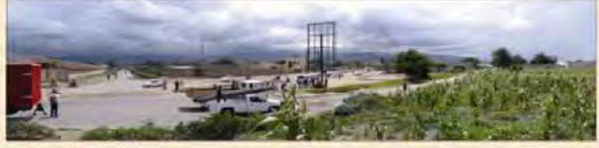
プロジェクト始点 (5枝路となっている。排水不良により雨期には道路が冠水する問題がある。)
