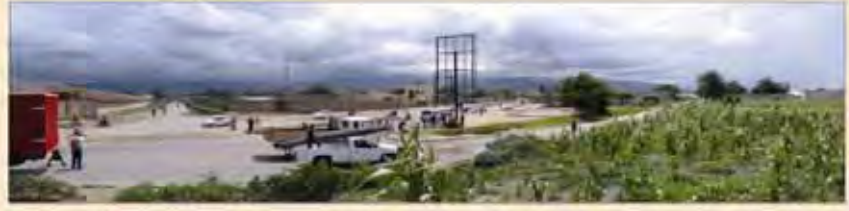
プロジェクト始点 (5枝路となっている。排水不良により雨期には道路が冠水する問題がある。)
