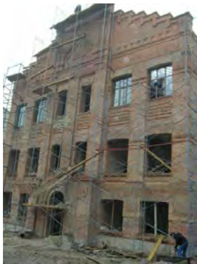
新ウクライナ日本センター（UAJC）ビル建設状況
