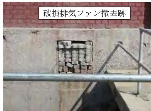
写真 R 2-1.4 シャドバーポンプ場の強制換気設備の現状
