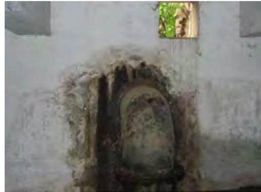
吐出管壁貫通部の損傷状況
