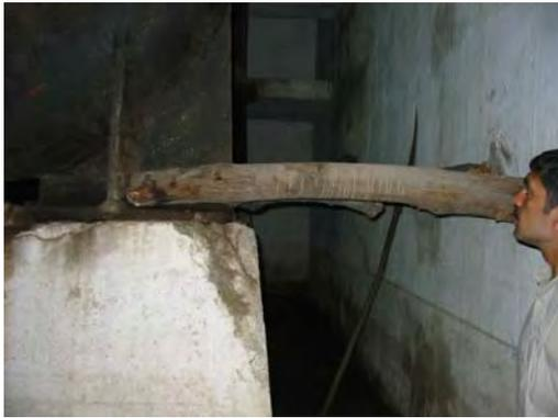
配管基礎の損傷状況
