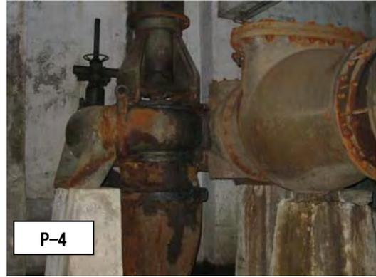
写真 R 2-1.11 ムルタンロードポンプ場のポンプ状況（その2）（左：P-3，右：P-4）
